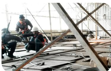
1 - Montagem da plataforma e/ou malha para proteção de equipamentos e pessoal no interior da construção
