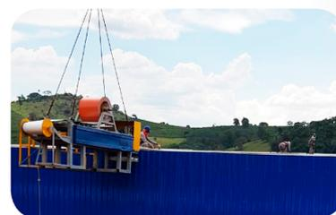
3 - Perfiladeira zipada produzindo telhas no comprimento adequado a cobertura
